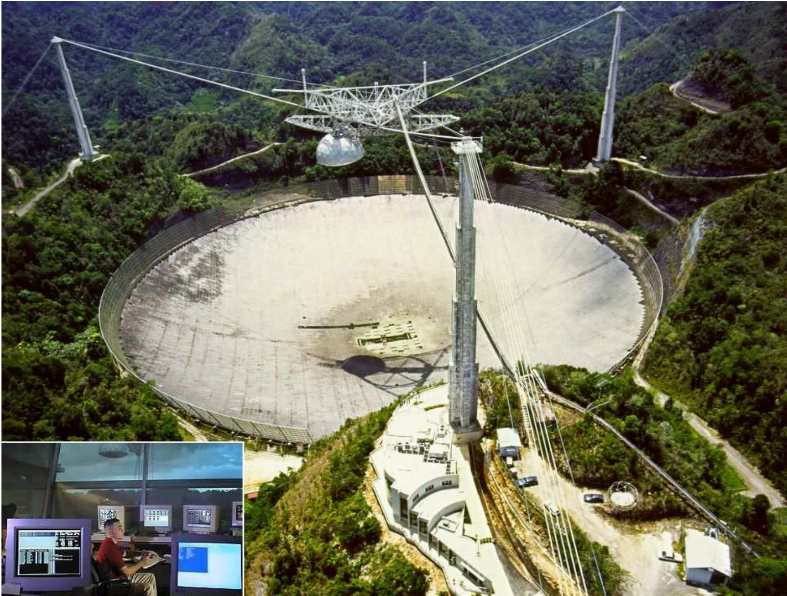
Parabole fixe avec foyer mobile Exemples ARECIBO D=300 m
