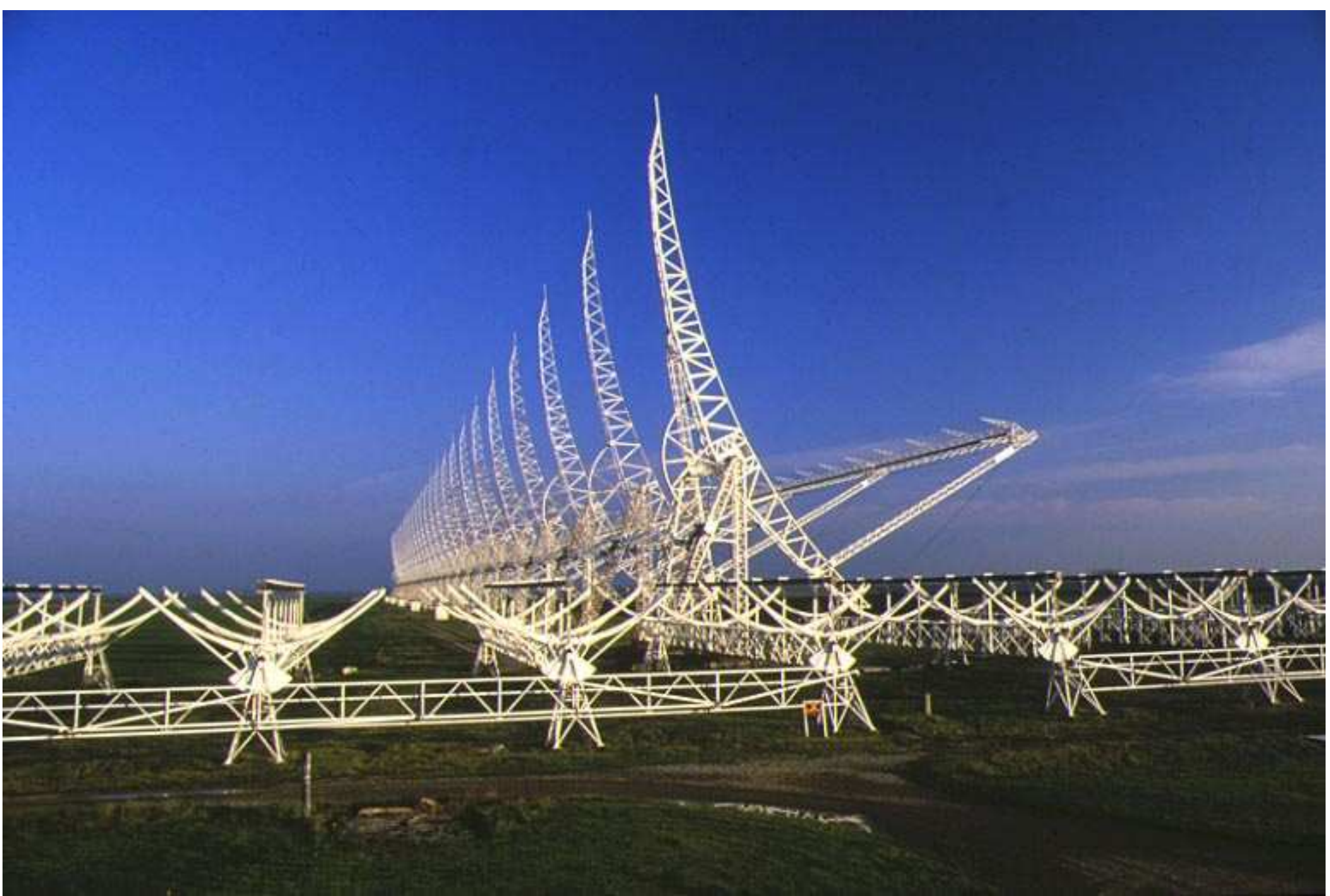
Réflecteur cylindro-parabolique orientable en site avec foyer mobile Exemple : Radiotélescope de BOLOGNE avec une longueur de 600 m
